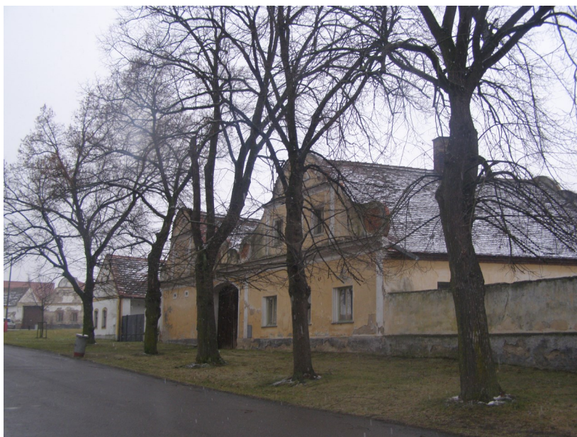
Lipové stromořadí v sídle (před odborně provedeným zdravotním řezem v koruně stromů) v Radošovicích, foto Lenka Vamberová
