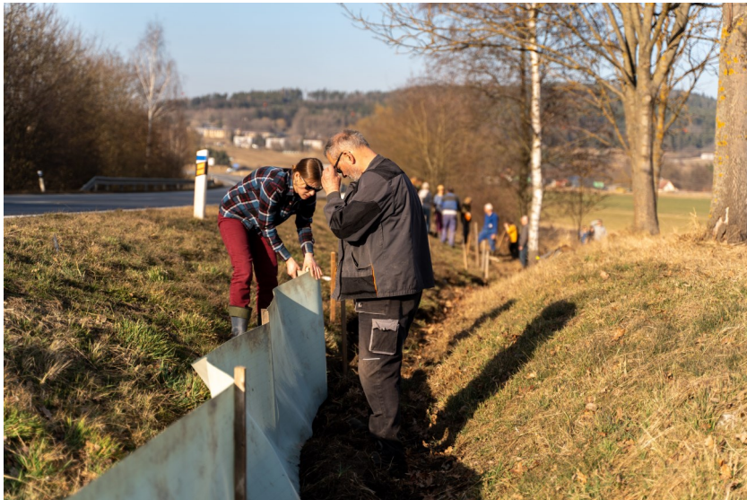
Stavba migračních bariér Volyňská, foto Lukáš Vincour
