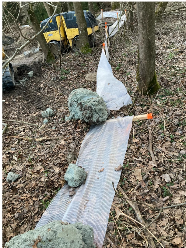
Opatření proti vniku obojživelníků na stavenišťe podle KŠH, foto Tereza Müllerová
